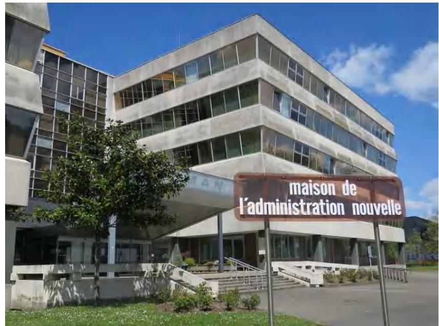
Nantes, Maison de l'Administration Nouvelle (2016)
